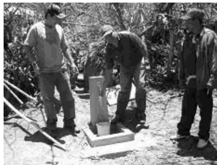
Construcción Sistema Agua Entubada Caserío Las Vegas de Curirca
